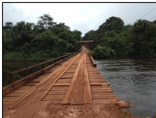
Figura 6.6-24 - Ponte sobre o rio Pantanarrí na estrada de acesso ao distrito de Clevelândia do Norte no bairro do Russo no município de Oiapoque/ AP.
