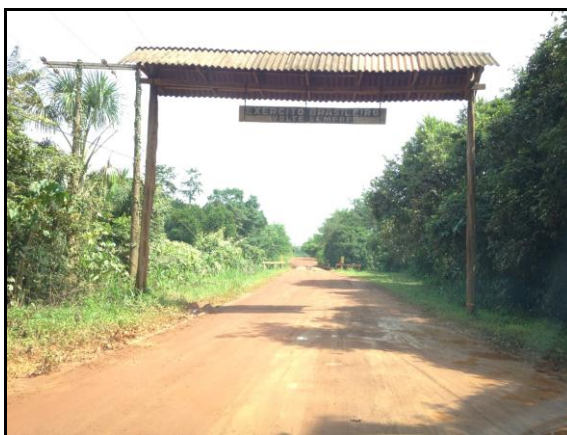
Figura 6.6-19 - Estrada não pavimentada que liga o distrito de Clevelândia do Norte à sede municipal de Oiapoque.
