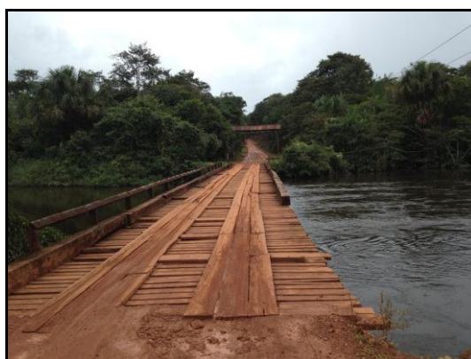
Figura 6.6-24 - Ponte sobre o rio Pantanarrí na estrada de acesso ao distrito de Clevelândia do Norte no bairro do Russo no município de Oiapoque/ AP.
