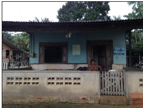
Figura 6.6-4 - Residência onde foi realizada entrevista com morador do bairro Sibéria em Clevelândia do Norte.
