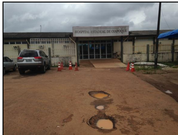
Figura 6.6-14 - Hospital Estadual de Oiapoque.
