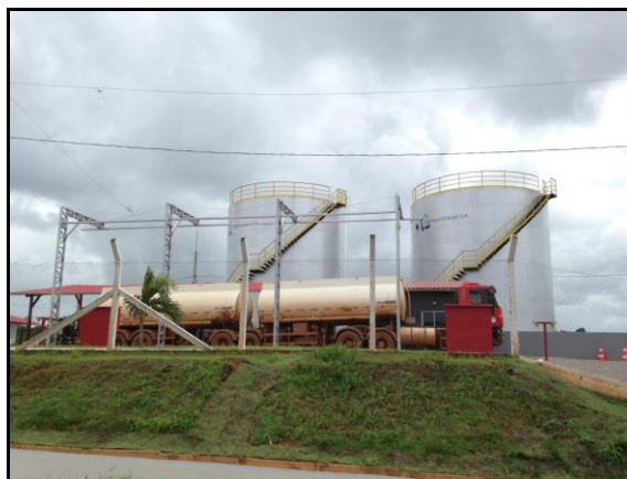
Figura 6.6-13 - Usina termelétrica da Oiapoque Energia S.A. movida a óleo diesel localizada na estrada com sentido a Clevelândia do Norte em Oiapoque/ AP.
