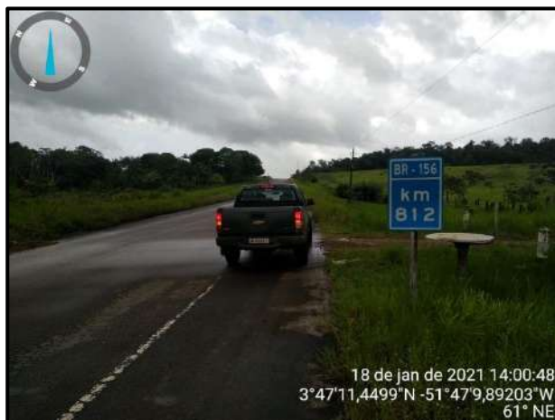
Foto 5-1 - Quilômetro 812 da Rodovia BR 156, que será utilizada como via de acesso. Coordenadas: 22N 412718,64; 418578,63 UTM.
