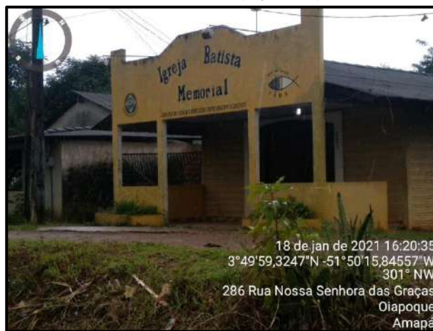
Foto 5-4 - Igreja identificada as margens da via de acesso que será utilizada, ponto sensível onde foi sugerida a instalação de uma placa de sinalização de trânsito próximo do local. Coordenadas: 22N 406995,29; 423732,27 UTM.
