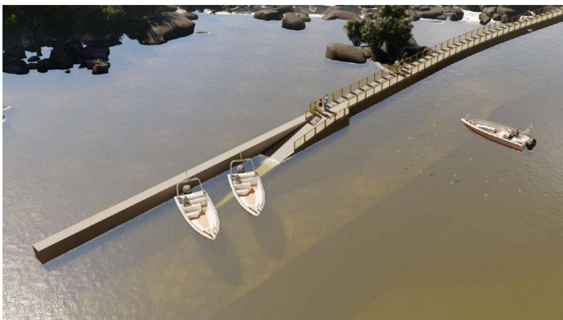
VISTA DA RAMPA DE MONTANTE
