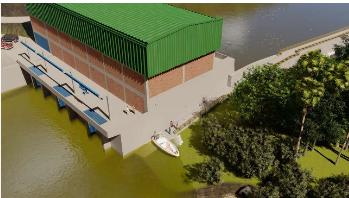
VISTA DA RAMPA DE JUSANTE
