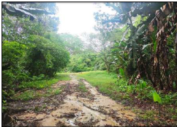
Figura 2-1 – Local do Canteiro de obras provisório
