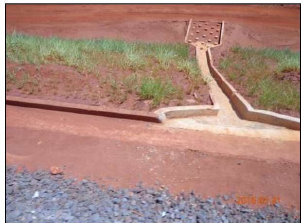
Figura 9-3 - Exemplo de dissipadores de energia hidráulica: descida d'água e bacia de amortecimento.
