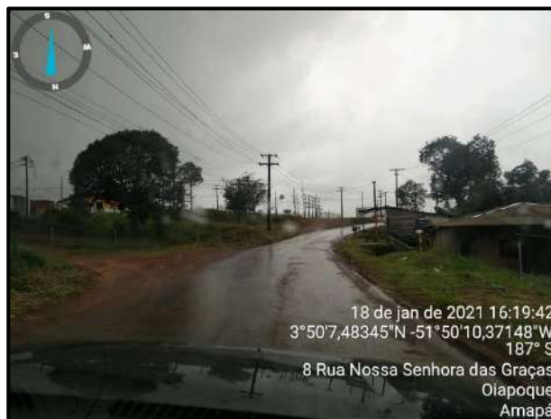
Foto 5-2 - Detalhe da pavimentação da estrada próximo da entrada da UTE, via que será utilizada como acesso. Coordenadas: 22N 407150,05; 423964,83 UTM.
