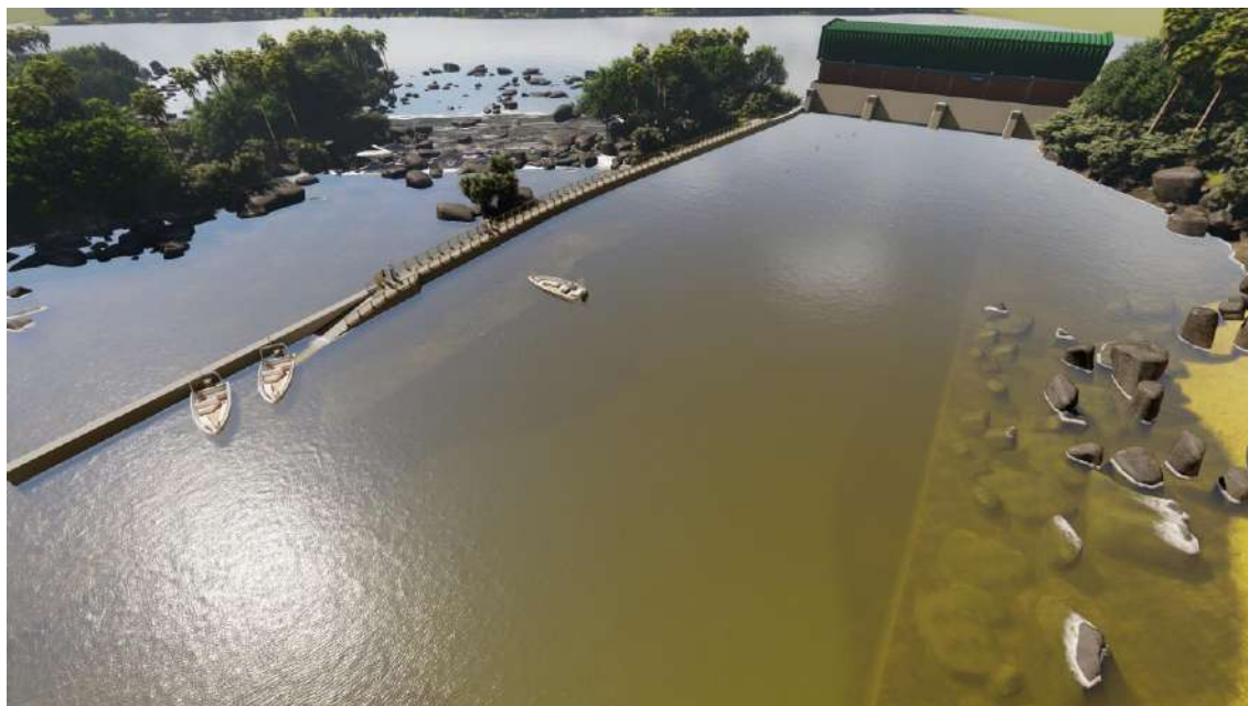
VISTA DE MONTANTE
