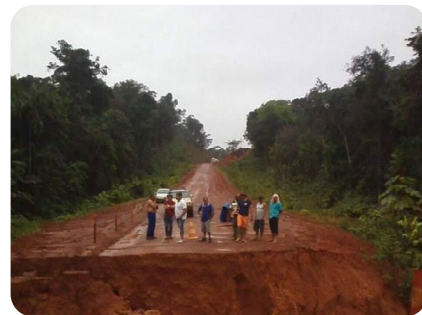
Fiscalização das obras de pavimentação da rodovia BR-156 2014 Foto: Ana Fonte
