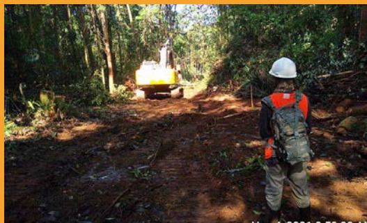
Acompanhamento supressão vegetal acesso mecanizada pedreira. Foto: Marcelo Morone
