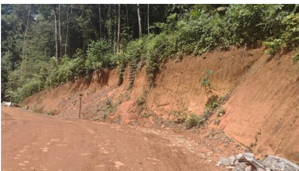
Foto antes da hidrossemeadura. Crédito: WSP Brasil
