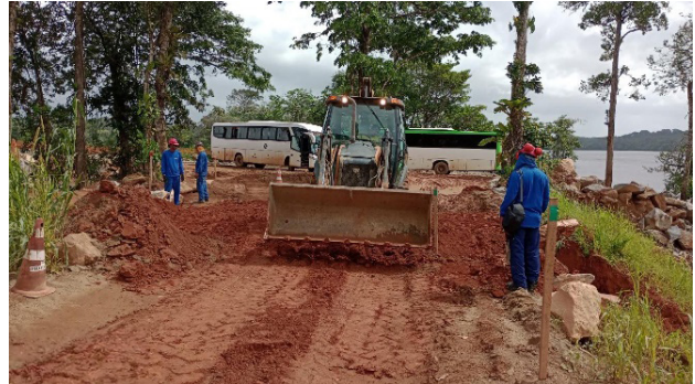
Abertura de acesso a jusante para instalação do dreno de bombeamento da enseadeira. Crédito: WSP Brasil
