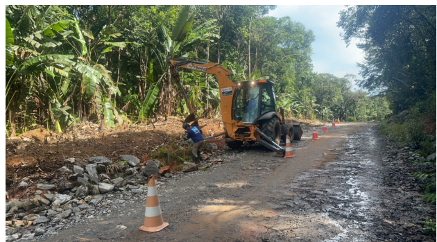
Escavação/Perfuração para instalação dos postes. Crédito: WSP Brasil
