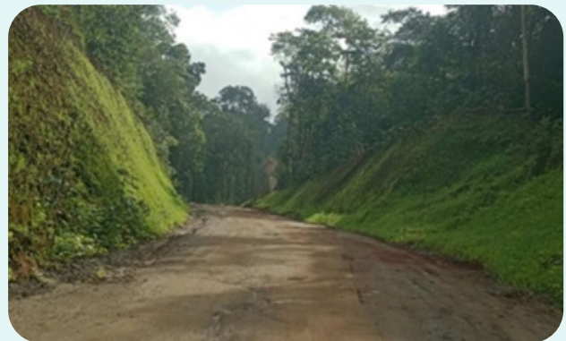
Foto do talude com proteção de vegetação estabelecida
